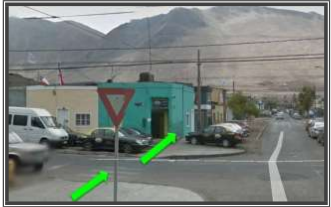
INTERSECCIÓN: ERNESTO RIQUELME/21 DE MAYO
